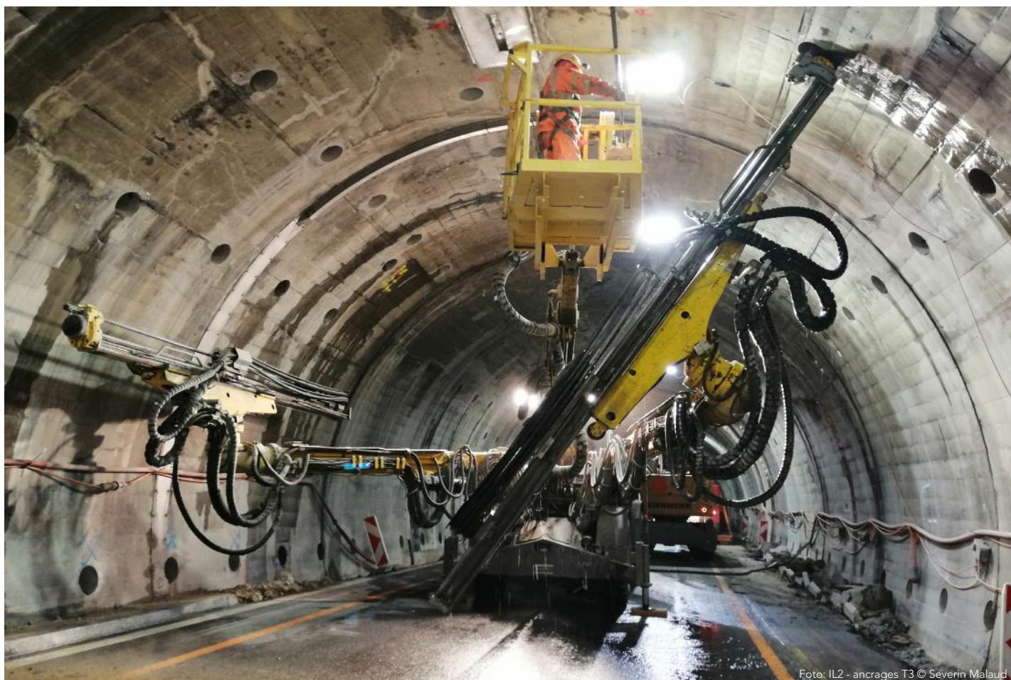
Foto: IL2 - ancrages T3 © Severin Malaud
